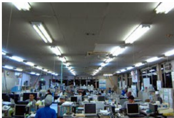
施工前 蛍光灯2本付きの事務所 平均照度(実測) 674Lux
